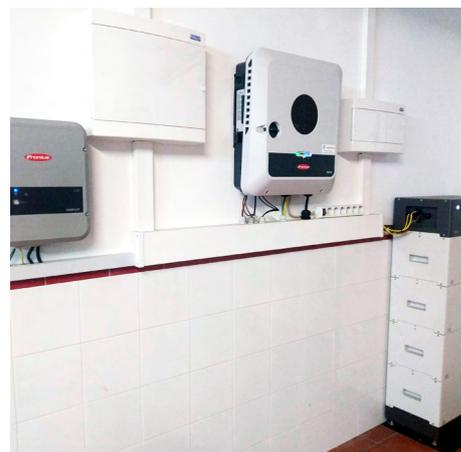
una **batería BYD** para almacenamiento energético y un **Ohmpilot**, el dispositivo desarrollado por Fronius que utiliza el excedente fotovoltaico para calentar agua.
